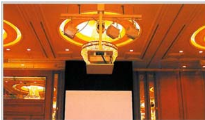
プロジェクターパイプ式昇降装置
