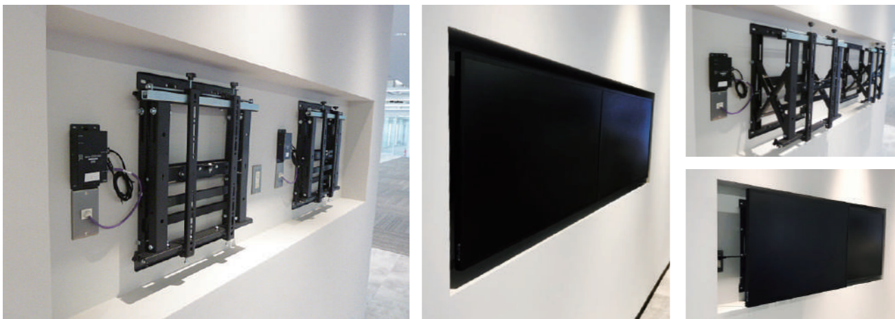
某施設 大型ディスプレイ埋込設置
